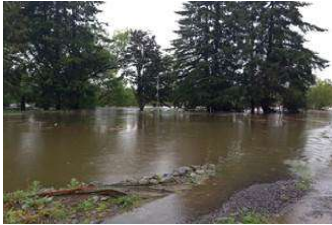
Raetihi sewage pond inundated
